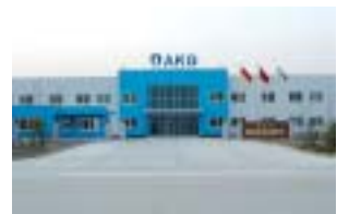
AKG Thermal Systems (Taicang) Co., Ltd., Taicang, China
